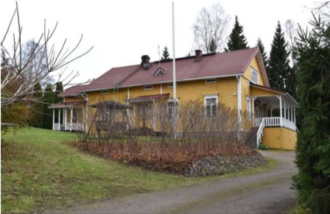
Kuva 14. Hirsimäen talo Mäkitiellä (Rakennusinventointi 2025, Ahola)
