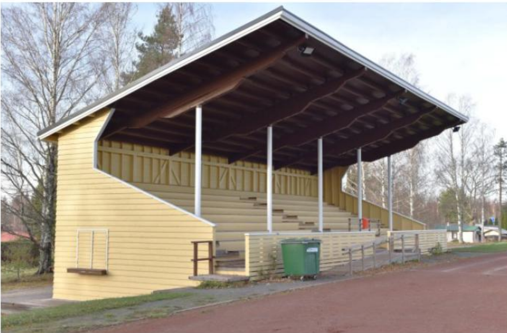
Kuva 7. Lautarunkoinen lippakatsomo, jossa on pukuhuonetilat sekä tilat kioskille ja välinevarastolle katsomon alapuolella.
